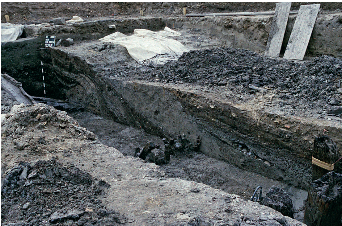
1 Xanten, CUT. Uferschutzanlage. Kantholzpfeiler (rechts) und kleinere Stecken mit eingeschütteten organischen Lagen (dunkel) und heller Senkerde.
