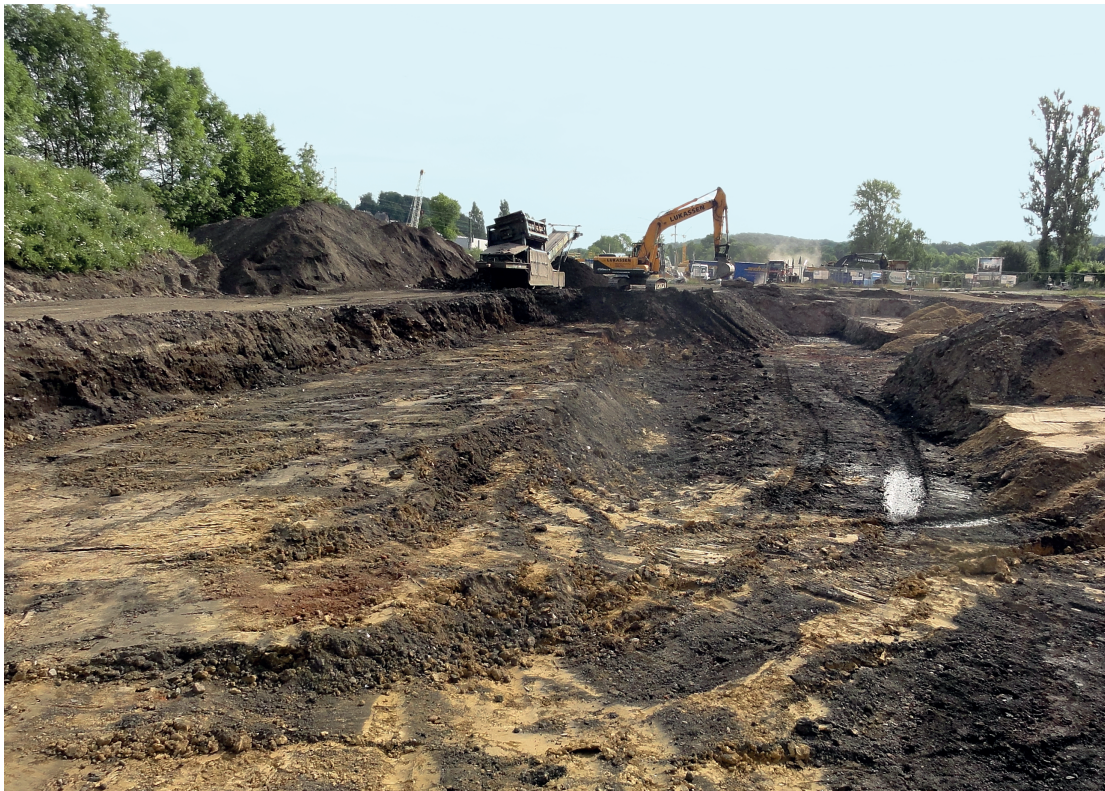
1 Essen-Kettwig. Blick nach Nordwesten über die Fläche während der Sanierung.
