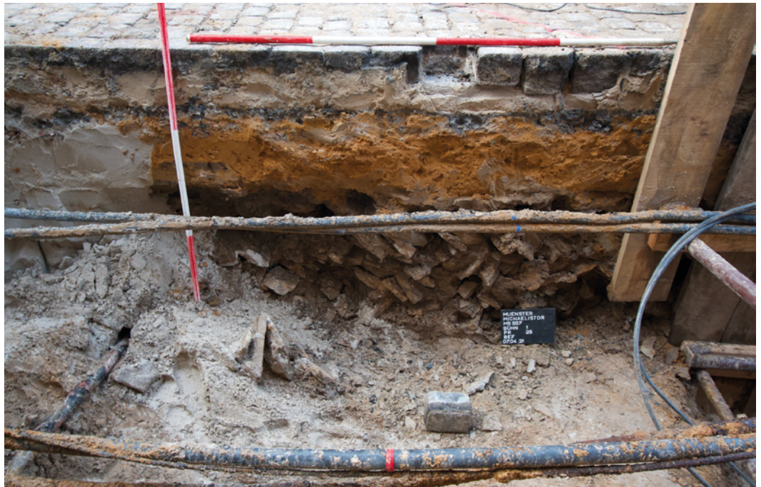
Abb. 5 Durch die massiven Eingriffe im Zuge des Leitungsbaus seit Beginn des 20. Jahrhunderts waren große Teile des Michaelistores gestört und instabil. Hier wurde der aus Packlagen bestehende Mauer Kern während der Tiefbauarbeiten dokumentiert, bevor er aus statischen Gründen verbaut werden musste (Foto: Stadtarchäologie Münster/K. Sina).
