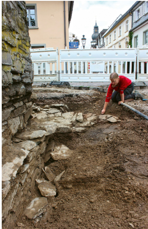
Abb. 3 Nordwestecke mit Blick in die Stadt: Auf der linken Seite ist die teilweise direkt unter der modernen Gartenmauer liegende westliche Zwingermauer erkennbar, die an eine Südwest-Nordost-ausgerichtete Mauer stößt, bei der es sich um die südwestliche Torturmmauer handeln könnte. Im gestörten Bereich östlich der Mauer ist schwach die gerötete Verfüllung mit hohem Holzkohleanteil erkennbar (Foto: LWL-Archäologie für Westfalen/H. Menne).
