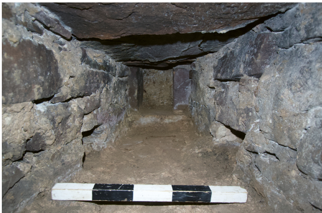
Abb. 2 Detailsicht des vorderen Schartenbereichs. Links und rechts sind die Aufnahmeöffnungen für das Prellholz zu sehen (Foto: Stadtarchäologie Höxter/J. Müller-Kissing).
