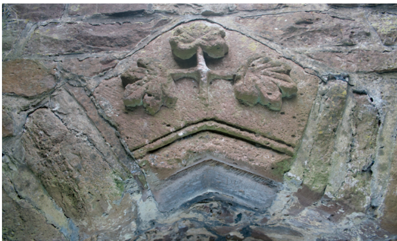
Abb. 5 Detailfoto des grob in das Gewölbe eingepasst spätgotischen Schlusssteins mit einem Weinblatt und zwei Eichenblättern (Foto: Stadtarchäologie Höxter/J. Müller-Kissing).
