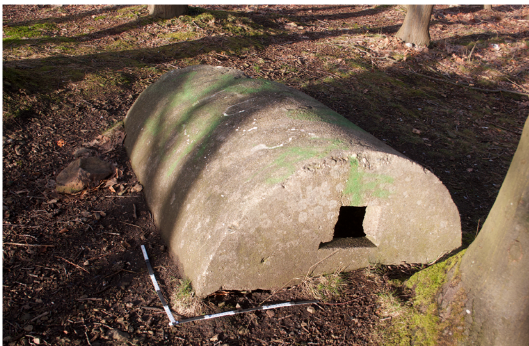
Abb. 5 Fla-Stellung auf dem Goldberg. Auf dem Gelände sind noch immer die Hauben der aus Betonfertigteilen zusammengesetzten Munitionsverschlüsse vorhanden (Foto: J. Müller-Kissing).
