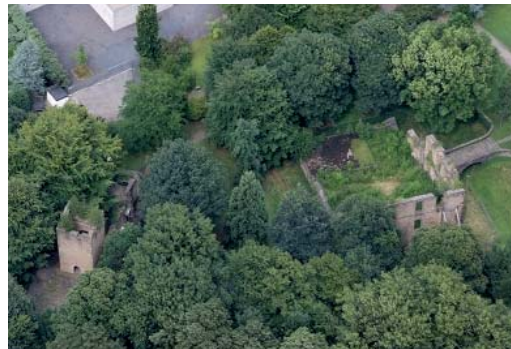
Abb. 2 Die Ruine von Haus Weitmar vor der Ausgrabung. Links die Überreste der Silvesterkapelle (Foto: LWL-Archäologie für Westfalen/S. Leenen).
