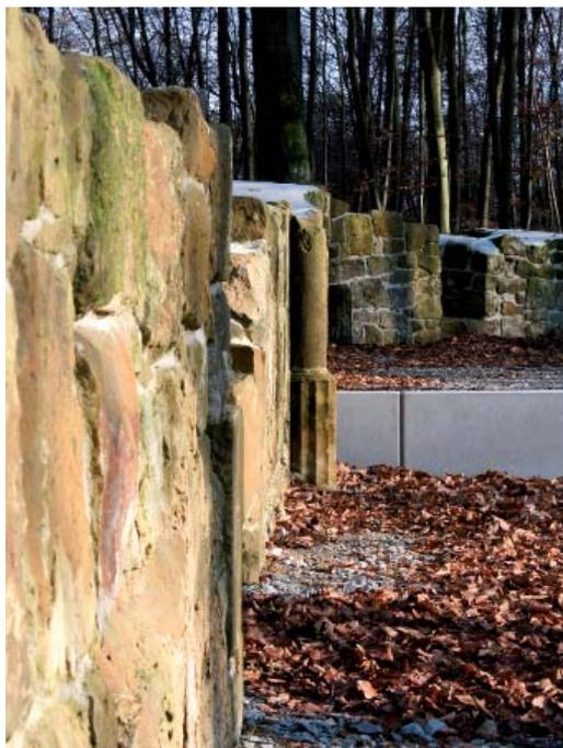
**Abb. 4** Die Stufe zwischen Schiff und Chor (Rest eines Lettners?) sowie Teile der Außenschale der Mauer mussten im Zuge der Restaurierung mit Beton komplett neu entstehen (Foto: LWL-Archäologie für Westfalen/C. Hildebrand).
