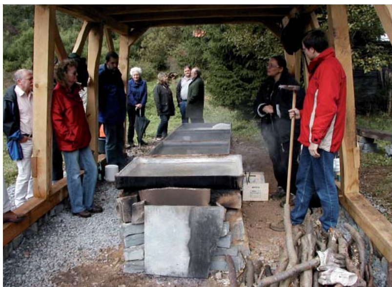
Abb. 3 Der fertige Ofen im Siedebetrieb. Der hölzerne Überbau wurde nach Vorbildern aus dem 12. Jahrhundert gefertigt (Foto: K. Otto).
