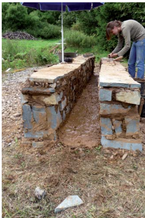
Abb. 2 Auf der eingeebneten Fläche einer alten Halde entstanden die beiden Mauern des Heizkanals. Die Bauzeit betrug etwa 1,5 Tage, geübte Ofenbauer benötigten vielleicht nur einen Tag (Foto: LWL-Archäologie für Westfalen/S. Jülich).
