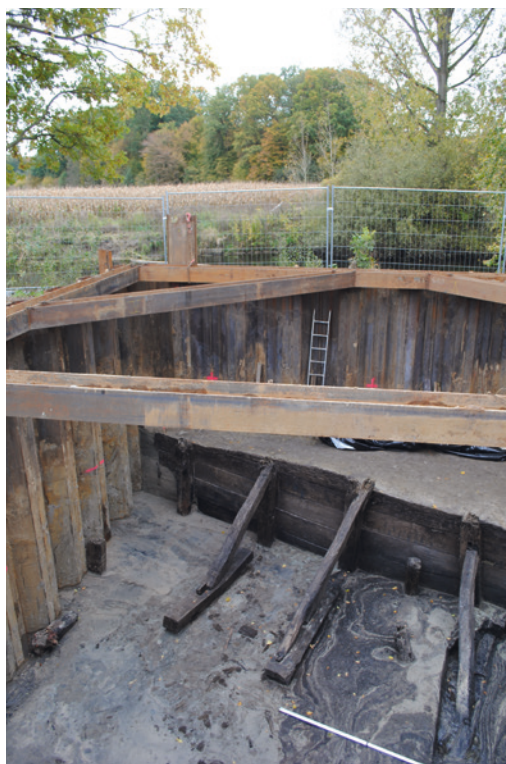
Abb. 2 Blick auf den südlichen Abschnitt des Holzbauwerkes. Hinter der Spundwand fließt die Werser (Foto: Stadtarchäologie Münster/U. Holtfester).
