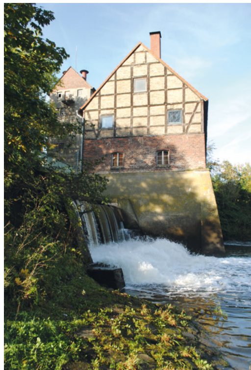
Abb. 1 Blick auf das Mühlengebäude mit dem Wehr im Vordergrund (Foto: Stadtarchäologie Münster/U. Holtfester).
