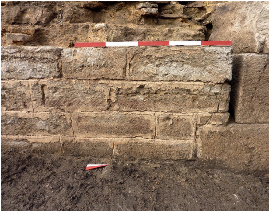
Abb. 4 Detailansicht des Mauerwerks mit Fugenmörtel (Kellenfugenstrich) (Foto: LWL-Archäologie für Westfalen/A. Bulla).
