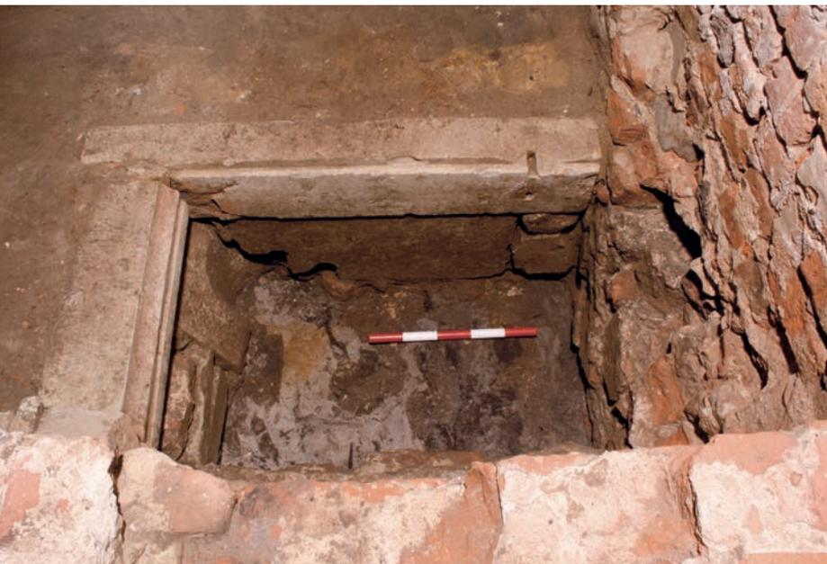
Abb. 5 Der Schacht g, in dem die Uhrgewichte gefunden wurden, von Westen, gesetzt aus wiederverwendetem Sandsteinmaterial, darin ein spätgotisches Gewände mit Birnstabprofil (Foto: LWL-Archäologie für Westfalen/ R. Klostermann).
