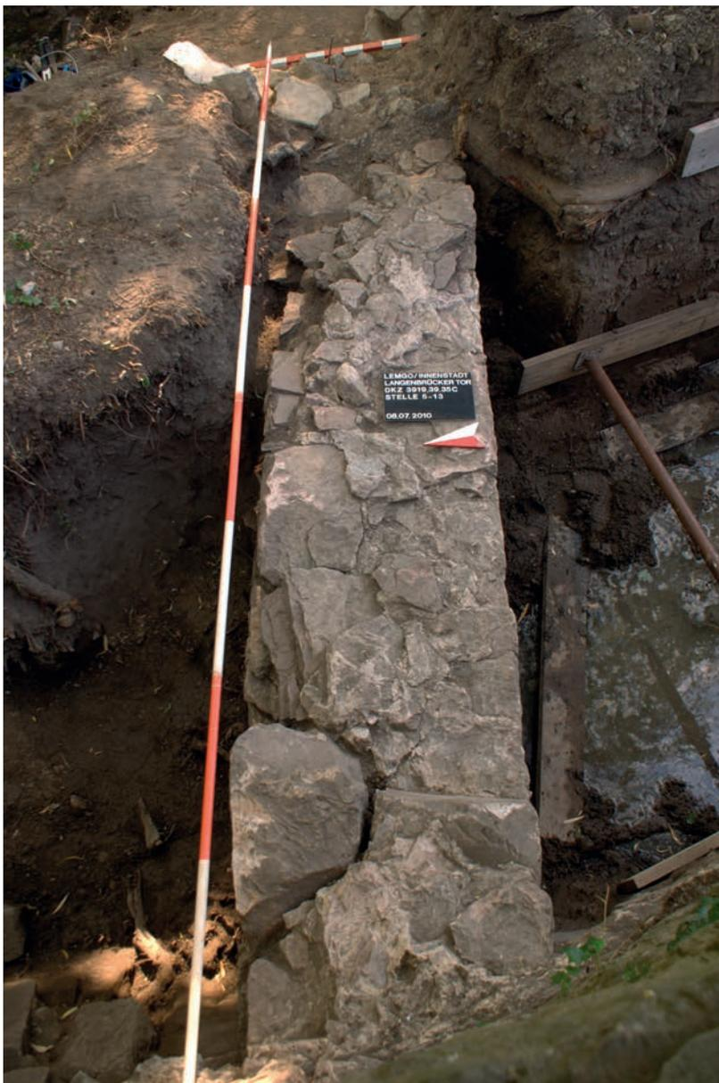
hörten zu den späteren Bauphasen der Brücke. Der oberste Mauerabschnitt G wies eine Bauinschrift mit der Jahreszahl 1896 auf. Ein Mörtelband zwischen den Mauerlagen E und F deutete auf eine Reparatur der Brückeneinfassung hin.
