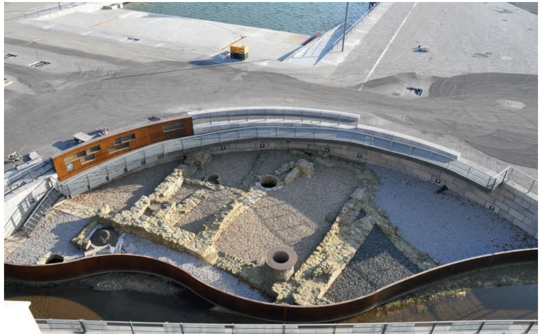
Abb. 1 Blick aus einem der oberen Stockwerke der Hörder Burg auf den »Hörder Burghof«. Im Vordergrund ist die Cortenstahlwand als Abgrenzung zum Hörder Bach, im Hintergrund der Rand des Hafenbeckens zum Phoenix-See erkennbar (Foto: Denkmalbehörde, Stadtarchäologie Dortmund/R. Grunenberg).
