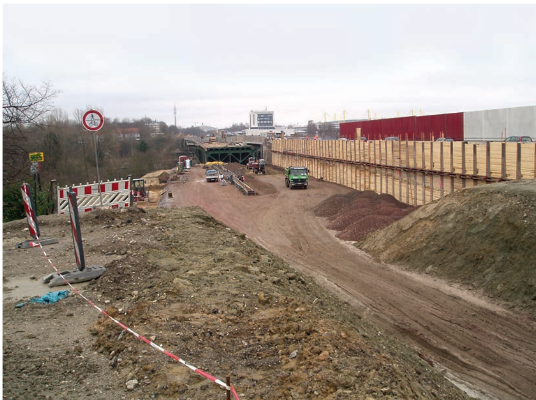
Abb. 1 Die Baustelle der B 1 bei Dortmund (Foto: LWL-Museum für Naturkunde/D. Grzegorzcyk).
