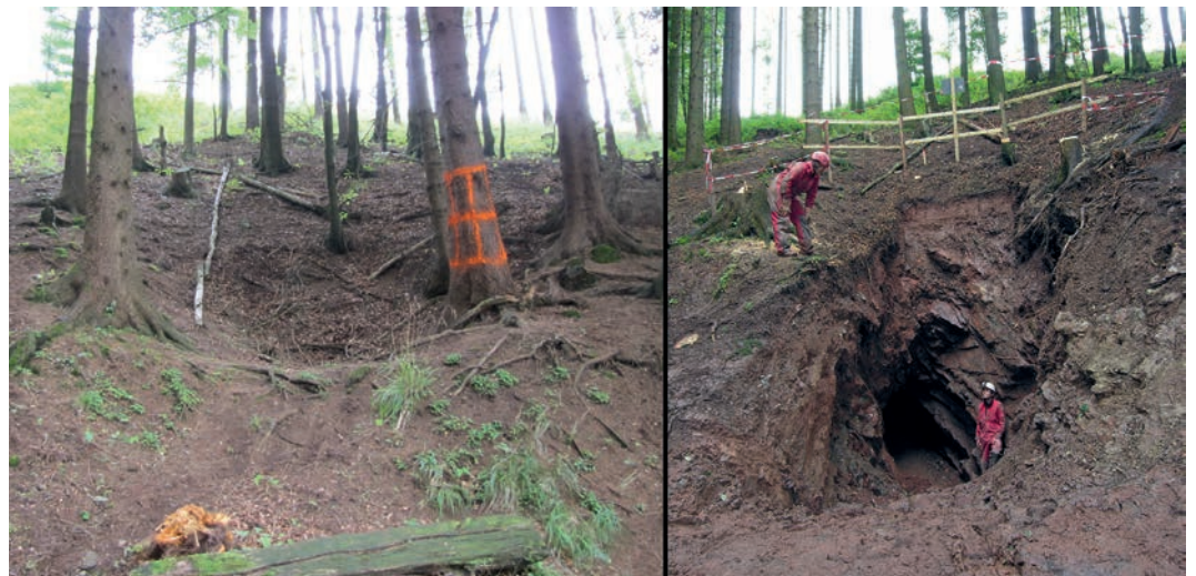
Abb. 3 Blick auf die Eintiefung im Berghang über dem Stollenmundloch vor und nach der Freilegung (Fotos: Deutsches Bergbau-Museum Bochum/F. Klein, G. Steffens).
