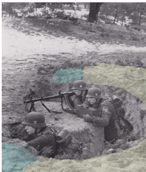
Abb. 3 Zeitgenössische Fotografie eines MG-Standes mit Rück- (hellgrün) und deutlich flacherer Schulterwehr (blau). Die Schulterwehren sind so ausgelegt, dass sie die Sicht nicht behindern (Foto: Sammlung Müller-Kissing).
