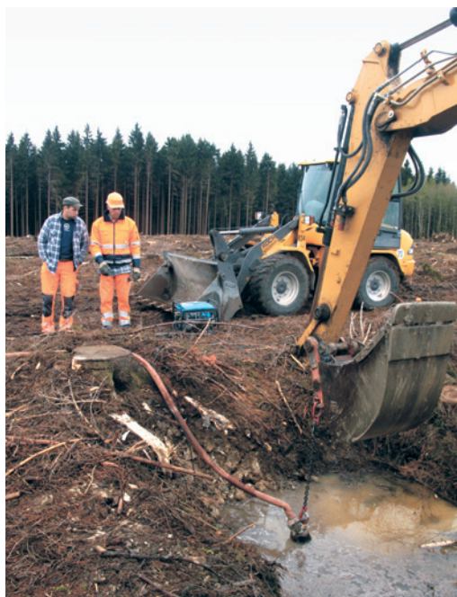
Abb. 3 Ständig nachfließendes Grundwasser erschwerte die Ausgrabungen erheblich. Selbst der Einsatz einer Schmutzwasserpumpe (rechts) konnte den Wasserpegel kaum senken (Fotos: LWL-Archäologie für Westfalen/ M. Zeiler).
