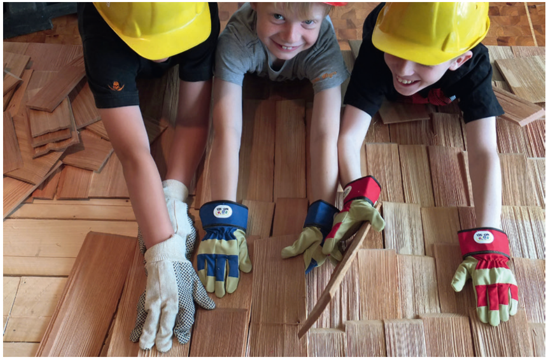
Abb. 4 Mit vollem Einsatz wird ein Dach mit Holzschindeln gedeckt (Foto: LWL-Römermuseum/T. Runkel).
