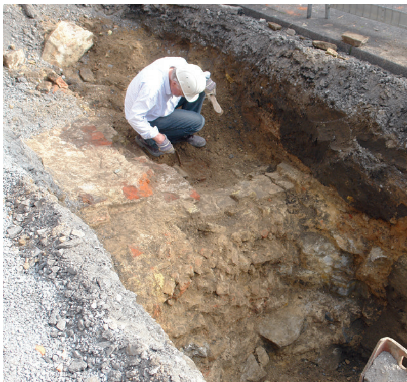
Abb. 1 Freilegung einer der Quermauern in der Franziskanerstraße im Kanalbauschaft in Hamm gegen Südwesten (Foto: LWL-Archäologie für Westfalen/A. Knäpper).
