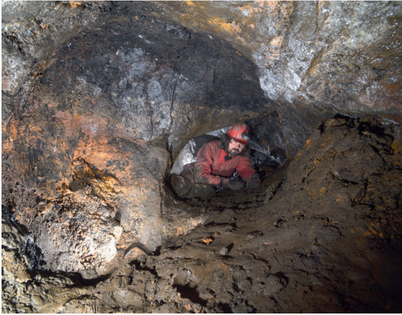
Abb. 5 Feuergesetzter Streckenabschnitt (links) und davor der Schnitt 4 (Foto: Deutsches Bergbau-Museum Bochum/P. Thomas).
