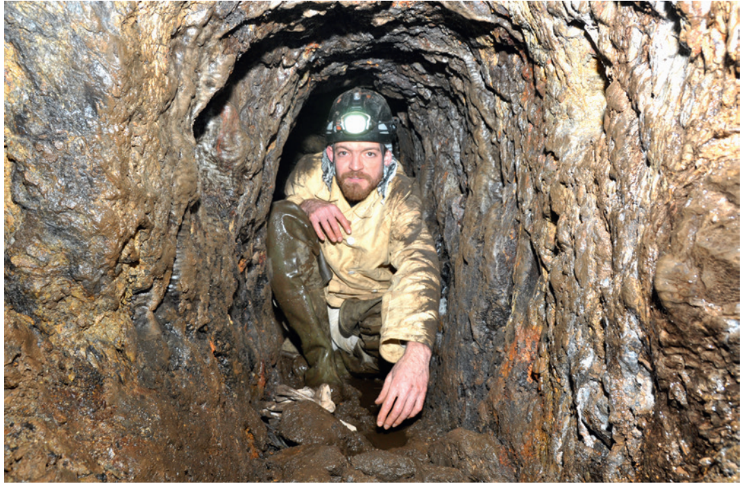
Abb. 2 Wie hier bei Strecke 2 im Alten Mann der Grube Victoria sind die Querschnitte durch geringe Durchmesser charakterisiert (Foto: Deutsches Bergbau-Museum Bochum/G. Steffens).
