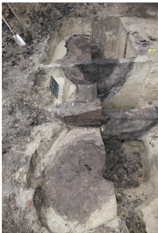
Abb. 5 Blick in die Baustelle unter dem Dortmunder Hauptbahnhof, Dezember 2015 (Foto: Denkmalbehörde, Stadt Dortmund/ R. Grunenberg).
