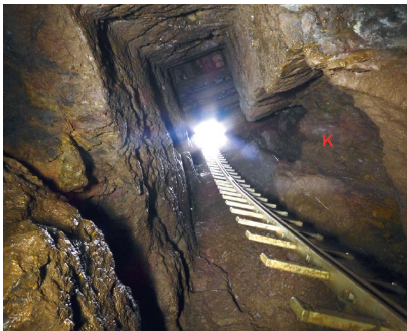
Abb. 2 (oben) Blick von unten in den noch erhaltenen Teil des Rosina Tagesschachtes. Gut erkennbar ist der rechteckige Querschnitt. Im rechten Schachtstoß (Westen) liegt der bereits beim Abteufen angeschnittene taube Erzgang (K). Den Abschluss des Schachtes zur Tagesöffnung bildet hier noch die in den 1920er-Jahren eingebrachte provisorische Schachtdeckung aus Eisenbahnschwellen (Foto: Altenberg & Stahlberg e. V./R. Golze).
