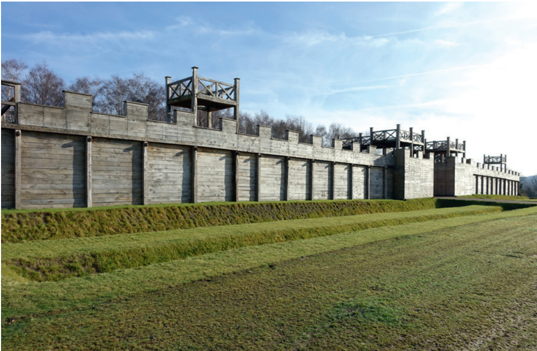
Abb. 9 Holz-Erde-Mauer mit Westtor der Römerbaustelle Aliso in Haltern am See (Foto: LWL-Archäologie für Westfalen/S. Brentführer).
