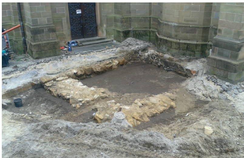
Abb. 3 Die Außenkante des romanischen Chornordwandfundaments, davor der spätere Anbau an der Nordostecke, vermutlich die Sakristei der Kirche, Blick von Nordosten (Foto: Denkmal3D, Vechta/I. Jüdes).
