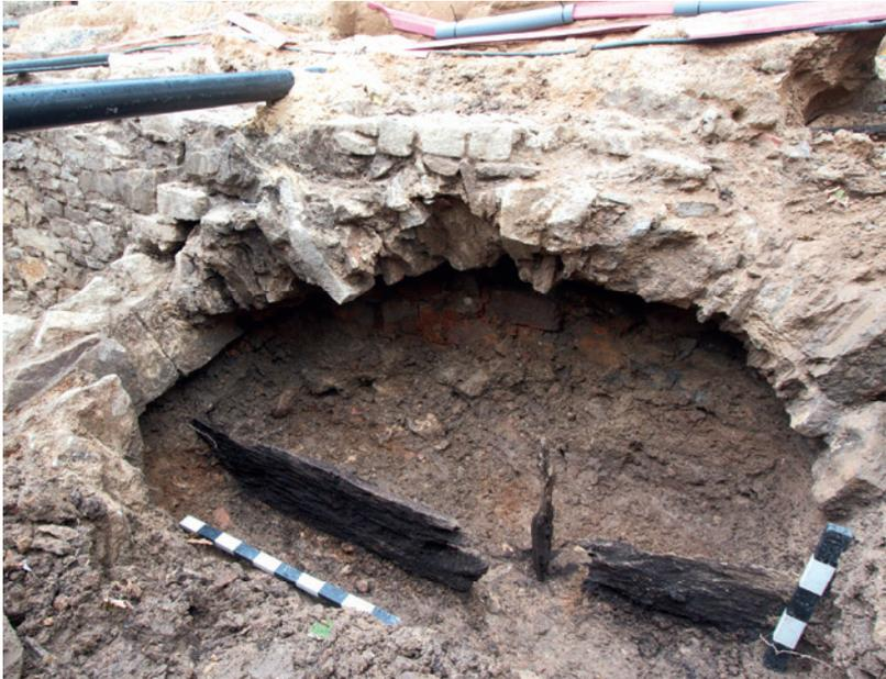
**Abb. 5** Blick auf die teileingerissene Gewölbetonne des Wasserdurchlasses im Außenwerk mit Resten der Holzwand. Im Hintergrund die Osthälfte des Torturms (Foto: Lippisches Landesmuseum Detmold/ J. Müller-Kissing).
