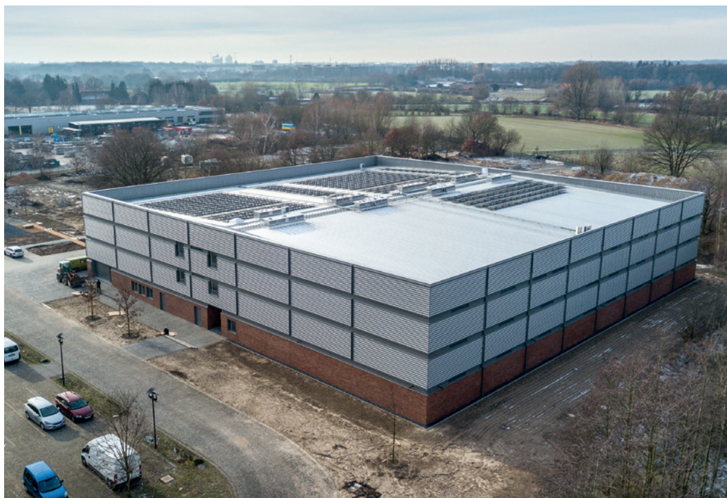
Abb. 10 Das neue Zentralmagazin bietet über 10.000 m 2 Sammlungs- und Archivfläche für unterschiedliche Kultureinrichtungen (LWL-Museum für Naturkunde/C. Steinweg).
