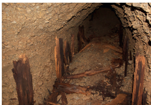
Abb. 1 Nutzungsstollen Befund 5, Blick in Richtung des Tagebruchs. Das herabgefallene Gestein hat die Stoßhölzer zum Teil in ihrer Position fixiert (Foto: Lippisches Landesmuseum Detmold/J. Müller-Kissing).
