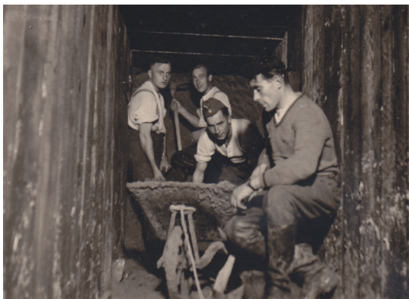
Abb. 4 Zeitgenössische Fotografie von Pionieren der Wehrmacht beim Stollenvortrieb. Auf dem Bild ist gut zu erkennen, dass die Schanzrahmen eingesetzt wurden, sobald an der Brust genug Platz geschaffen worden war (Foto: Sammlung J. Müller-Kissing).
