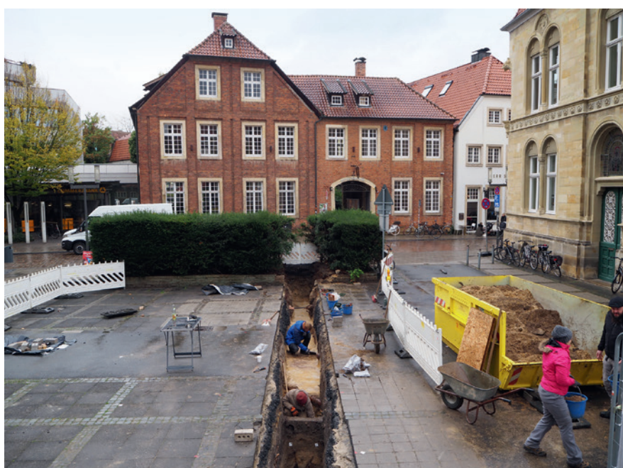
Abb. 3 Fernwärmeleitungsgraben an der St.-Ludgeri-Pfarrkirche von Osten (Foto: Stadtarchäologie Münster/P. Hessel).
