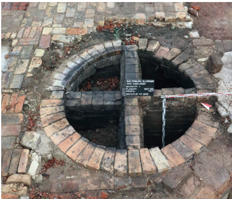
Abb. 4 Gaswechselgrube als charakteristische Rundkonstruktion mit kreuzförmiger Unterteilung. Über die einst aufsitzende »Wechseltrommel« ließ sich die Richtung der Gaszufuhr in den Glasofen steuern. Die feuerfesten Schamottesteine wurden größtenteils von den »Vereinigten Großalmeroden Thonwerken« bezogen (Foto: LWL-Archäologie für Westfalen/B. Grundmann).
