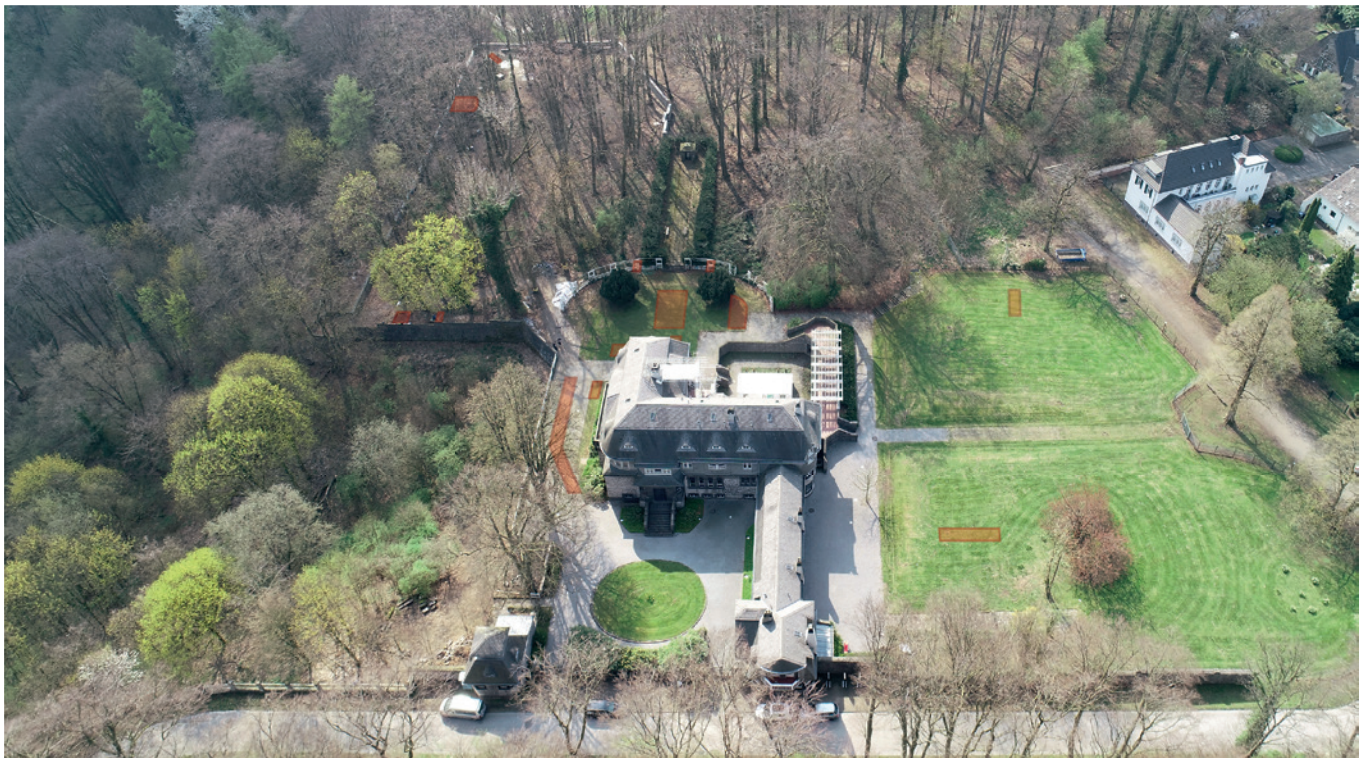
Abb. 3 Das Drohnenfoto zeigt die Gartenanlage mit dem Hohenhof von Norden. In rot markiert sind die wichtigsten Sondagen (Foto: LWL-Archäologie für Westfalen/L. Cramer).
