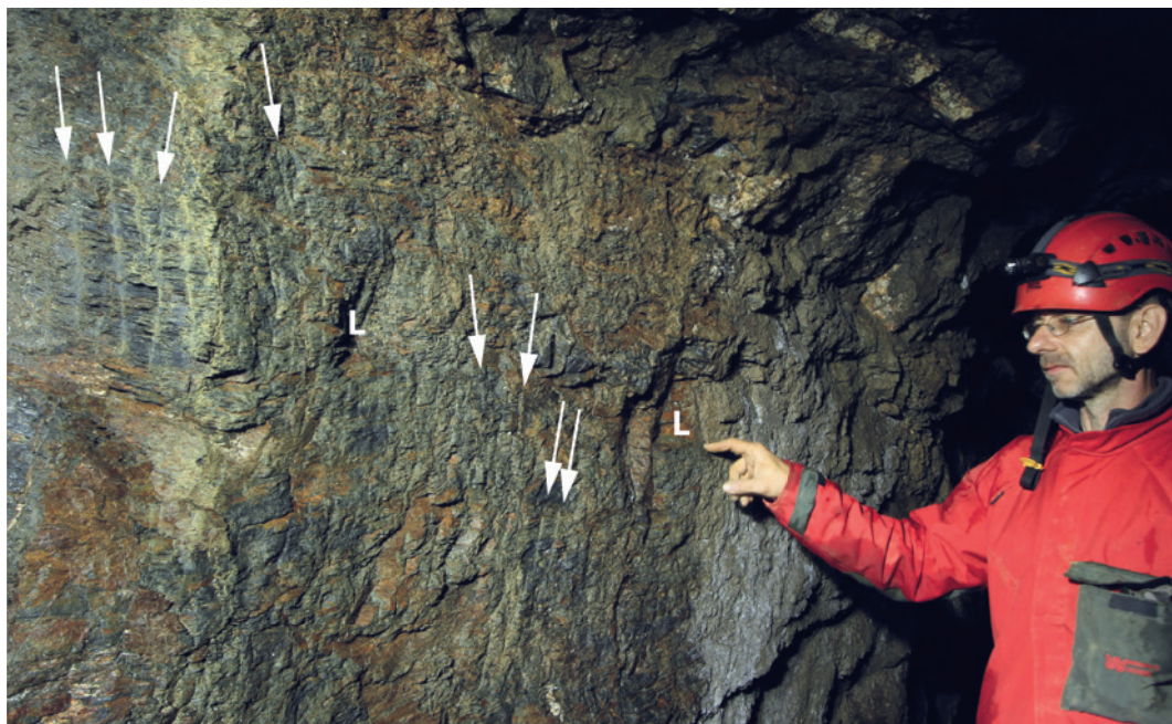
Abb. 3 Westlicher Stollenstoß der Grube Himmereich mit Schräm Spuren (Pfeile) sowie Lampennischen (L) der ältesten Bergbauphase (Foto: LWL-Archäologie für Westfalen/M. Zeiler).
