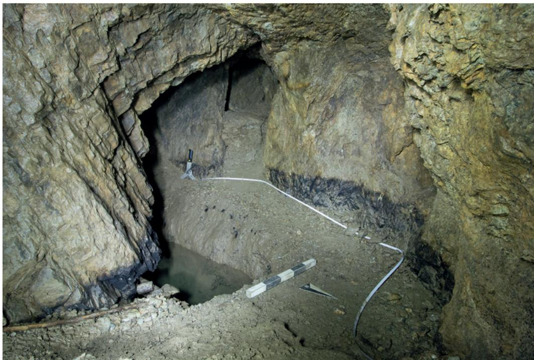
Im Stollen findet sich ein Durchbruch zu einer ausgearbeiteten Abbaukammer (Abb. 4), die entweder vor dem Stollenbau oder danach entstand. Denn wie beim »Alten Ruckel« wurde auch dieses Bergwerk im 19. Jahrhundert erneut aufgesucht und beispielsweise ein neuer Schacht in größeren Tiefen angelegt, der aber heute abgesoffen (geflutet) ist (Abb. 5).
