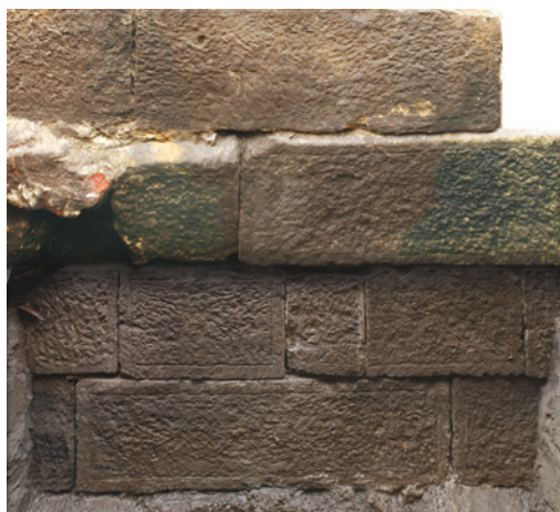
Abb. 6 Fotogrammetrisch erstellte Ansicht der Stadtmauer entlang der Ems (Foto: LWL-Archäologie für Westfalen/L. Fischer, R. Klostermann).
