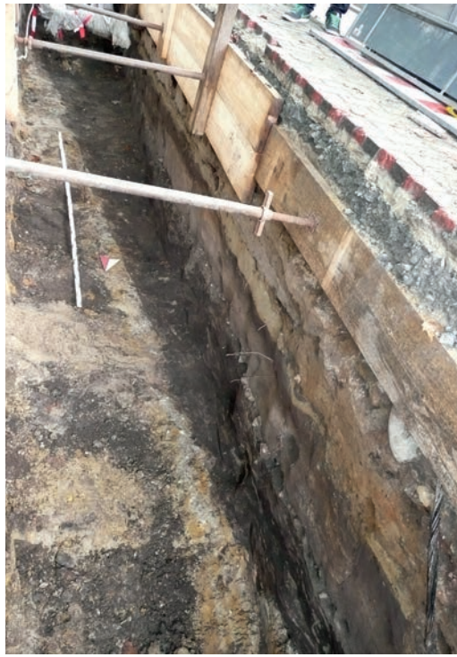
Abb. 4 (links) Königsstraße. Ostkante eines Grabens im Süden, über den im Profil eine mittelalterliche Straßenpflasterung zieht (Foto: Stadtarchäologie Münster/H. Jakobi).
