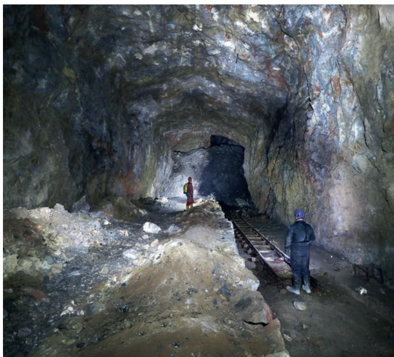
Abb. 4 Blick in einen der großen Stollen der Untertageverlagerung »Schwalbe 1« bei Hemer-Deilinghofen. Dieses unvollendete Stollensystem weist noch die Verladerampe und die Gleise der Feldbahn auf (Foto: LWL-Archäologie für Westfalen/T. Poggel).
