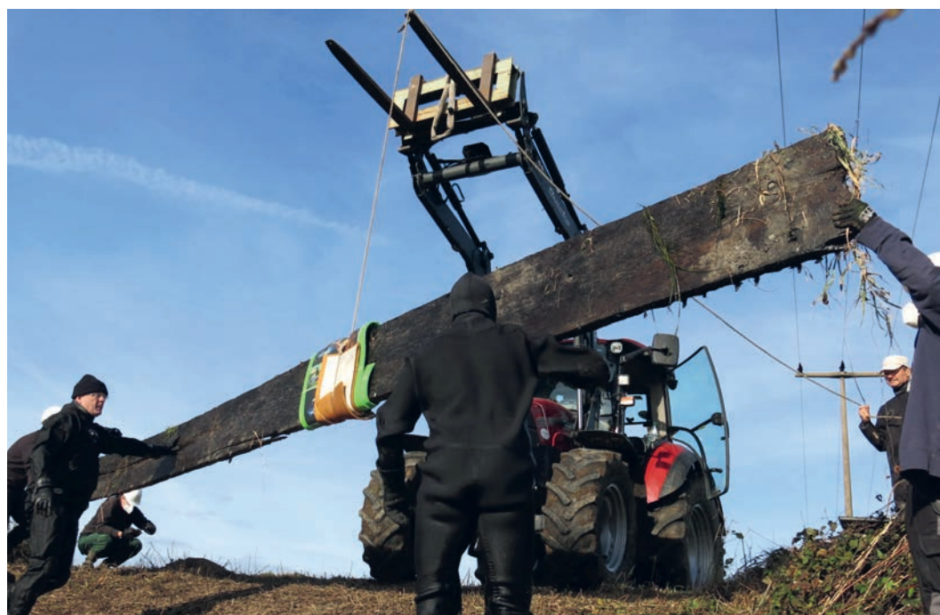
Abb. 3 Die Bergung der schweren Bauteile (hier eine Bodenplanke) erfolgte mithilfe eines Frontladers (Foto: P. Ferlemann, Lippstadt).
