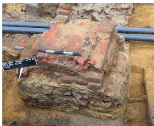
Abb. 2 Pfeilerfundament an der Nordwestecke des alten Rathauses (Foto: Jentgens & Partner Archäologie/R. Machhaus).
