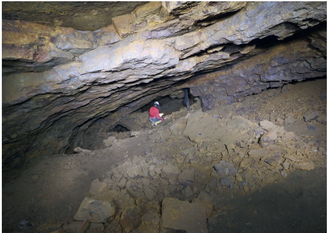
Abb. 4 Blick in eine bereits teilverbrochene Abbauhalle mit eingespanntem Stempel nahe einem Pfeiler (Foto: LWL-Archäologie für Westfalen/T. Poggel).
