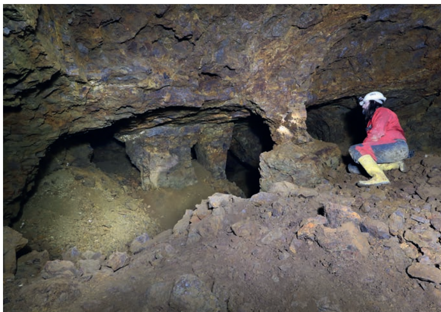
Abb. 3 Der Pfeiler rechts ist in der Mitte deutlich dünner, während der Pfeiler dahinter innen vertikal durchlocht wurde (Foto: LWL-Archäologie für Westfalen/T. Poggel).
