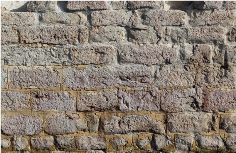
Abb. 1 Bei den Arbeiten wurde Wert auf Details gelegt. So sind auch kleinteilige Aspekte, etwa die in Fischgrätmuster geflüchten Schauseiten von Steinen oder hochwertiger historischer Fugenmörtel, auch weiterhin für Experten wie Laien nachvollziehbar (Foto: LWL-Archäologie für Westfalen/M. Thede).
