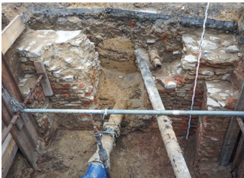
Abb. 5 Fundamentmauern der Brücke über den äußeren Stadtgraben. Der Mittelteil ist durch moderne Leitungen stark gestört. Vorne sind die etwas kleineren Stützmauern zu erkennen (Foto: Stadtarchäologie Münster/F. Hahn).
