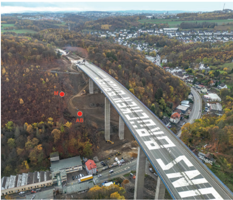
Abb. 2 Blick von Nordosten auf die Talbrücke Rahmede und die Baustraßen am Südende der Brücke samt Meiler- (M) und Bergbaufundstelle (AB) im Wirkungsbereich der Baustelle (Foto: LWL-Archäologie für Westfalen/M. Zeiler).
