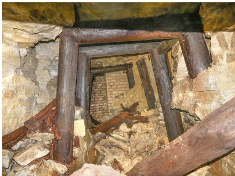
Abb. 4 Blick in den Bunkerstollen mit Türstockverbau. Hinten sind zwei versetzte Türwangen erkennbar (Foto: EggensteinExca GmbH/ R. Gündchen).
