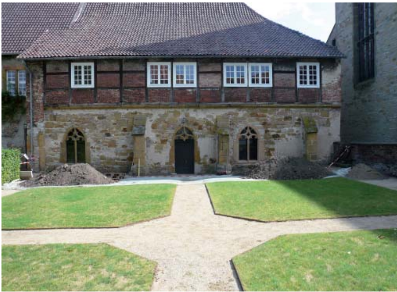
Abb. 2 Der Ostflügel des ehemaligen Klosters Herzebrock mit dem spätgotischen Kreuzgang von Westen während der Arbeiten im Herbst 2009 (Foto: LWL-Archäologie für Westfalen/O. Ellger).
