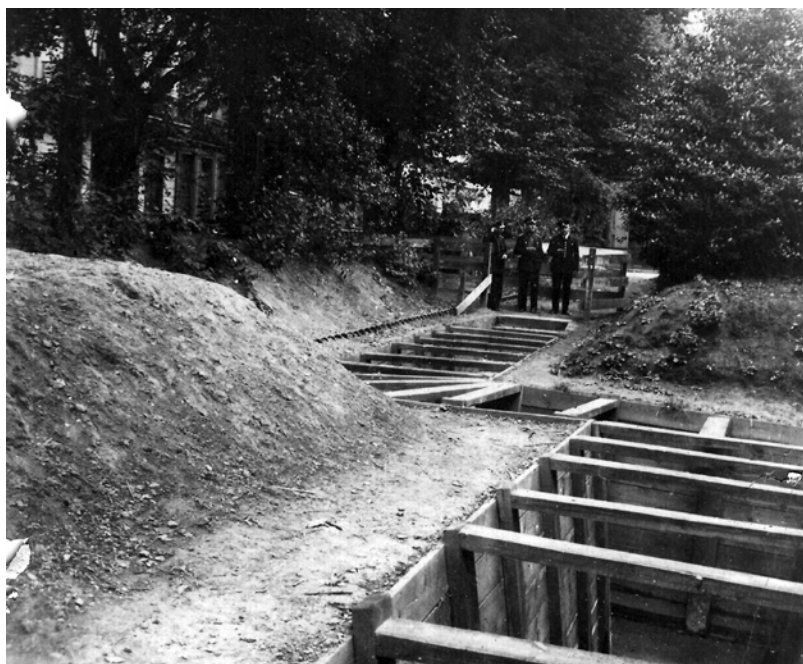
Abb. 3 Bild eines von Wehrmachtsangehörigen in Lille (Frankreich) gebauten, ungedeckten, Splittergrabens. Die Holzauskleidung des Grabens in Höxter wurde ähnlich ausgeführt (Foto: Sammlung Müller-Kissing).
