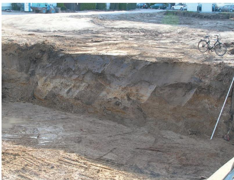
Abb. 5 Baugrubenprofil mit grauem Sedimentband über dem gelben anstehenden Lösslehm (Foto: LWL-Archäologie für Westfalen/S. Spiong).
