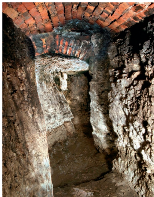
Abb. 3 Der Hauptarm des unterirdischen Kanalsystems (Foto: Städtische Museen Rheine/Carlo).
