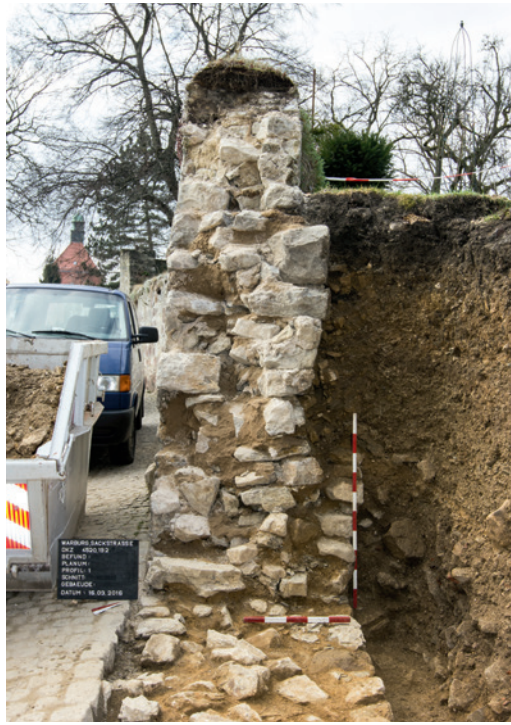
Abb. 4 Profilansicht der Zwingermauer. Deutlich erkennbar der im oberen Bereich aufgebrachte moderne Mauerwerkabschnitt (Foto: LWL-Archäologie für Westfalen/ M. Thede).
