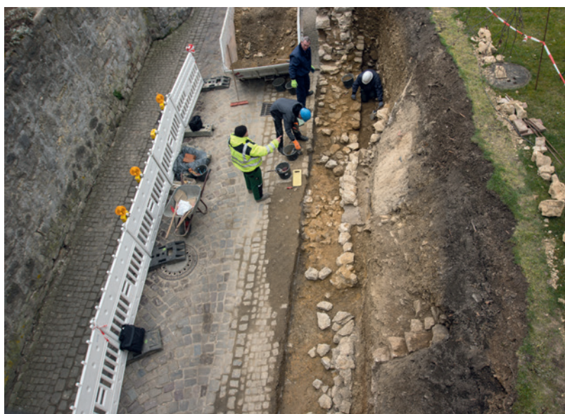
Abb. 3 Blick auf das freigelegte Fundament des abgebrochenen nördlichen Mauerwerksabschnittes der Zwingermauer (Foto: LWL-Archäologie für Westfalen/M. Thede).
