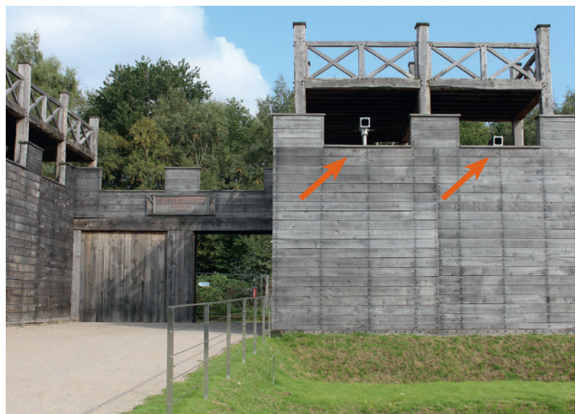
Abb. 1 Zwei »Ferngläser« auf dem rekonstruierten Westtor ermöglichen einen ersten »Blick in die Römerzeit« (Foto: LWL-Archäologie für Westfalen/ R. Wiechers).
