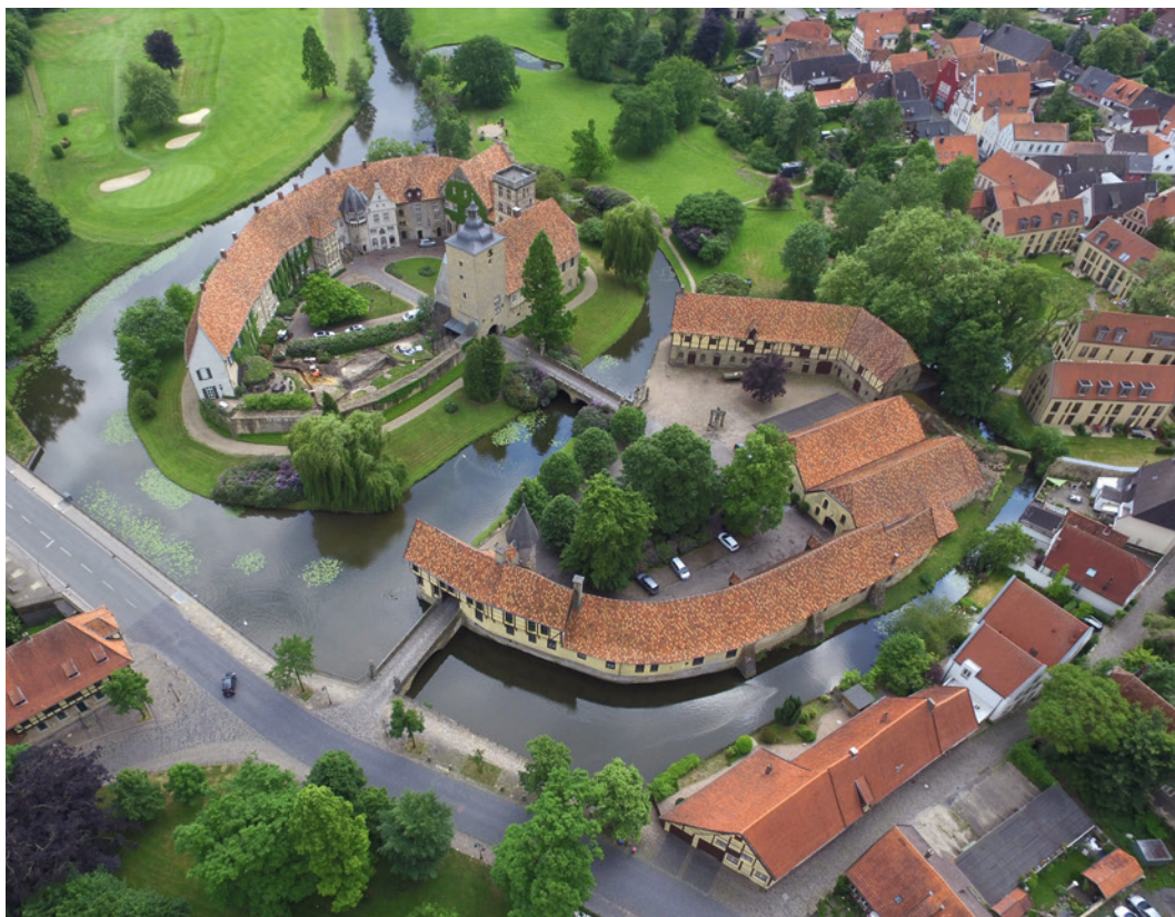
Abb. 1 Blick von Nordwesten auf Schloss Burgsteinfurt. Haupt- und Vorburg werden durch Gräften geschützt, die von der benachbarten Steinfurter Aa gespeist werden (Foto: LWL-Archäologie für Westfalen/R. Klostermann).
